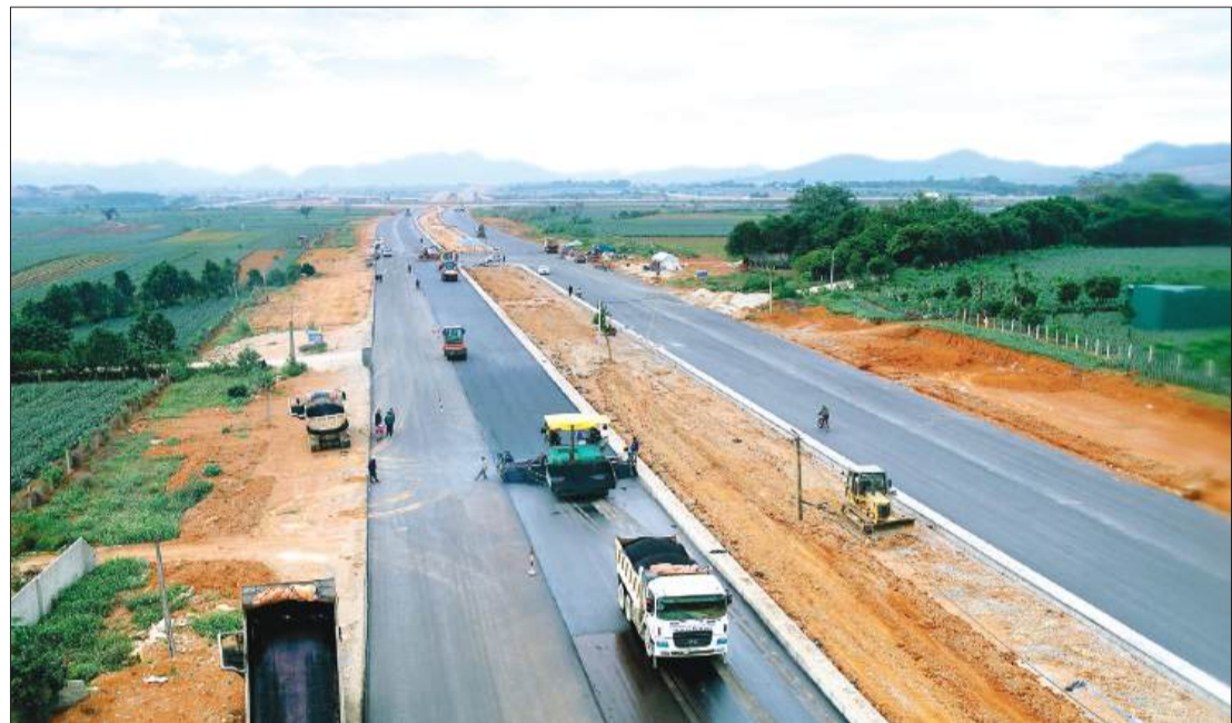
Khẩn trương thi công tuyến đường Đông-Tây (giai đoạn 1).
