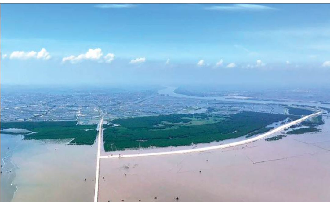
Tuyến đường đê biển Bình Minh 4 (giai đoạn 1) đã hoàn thành và đưa vào sử dụng.
